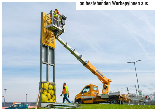
Markus Aichinger montiert Einnietmuttern zur Befestigung der Ringschrauben. Diese dienen später als Anschlagpunkte zum Einheben der Infopoints und Regionsportale bei der Montage. Nach dem Versetzen werden die Ringschrauben wieder entfernt.
